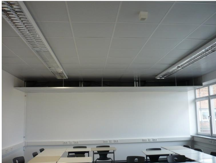
Abbildung 5-4: Foto der Kühldecke in Raum 319
