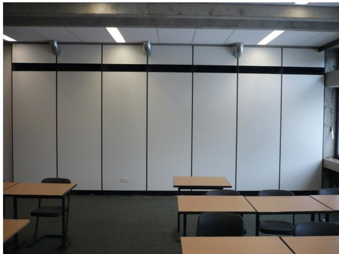
*Abbildung 6-30: Geschlossene Klimawand (Sanierung im laufenden Betrieb)*
