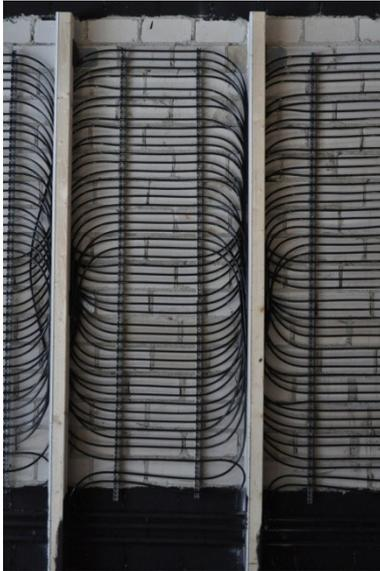
Abbildung 8-2: Schacht der Klimawand im Rohbau
