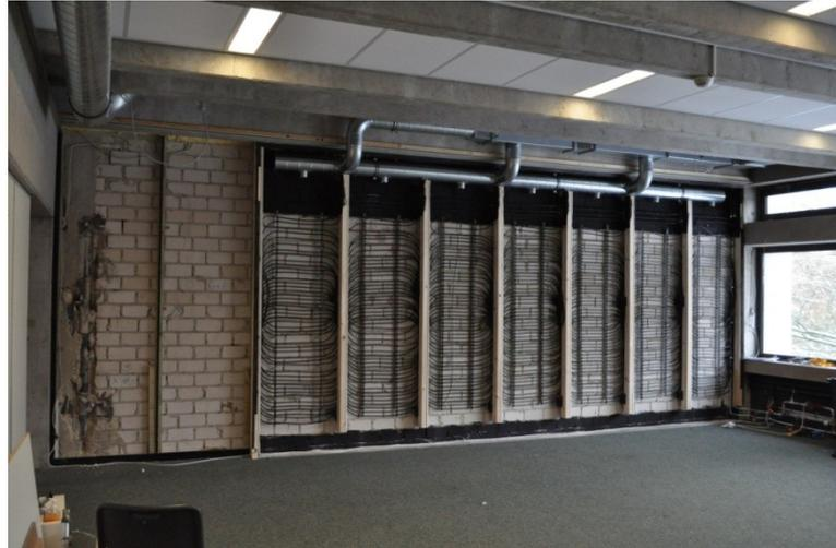
Abbildung 8-3: Ansicht der Klimawand im Rohbau
