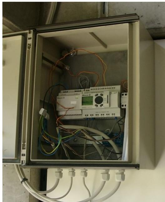
Abbildung 6-34: Das Innere des Schaltschranks im Klassenraum<sup>37</sup>
