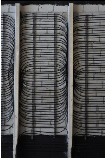
*Abbildung 6-28: Schacht der Klimawand im Rohbau*
