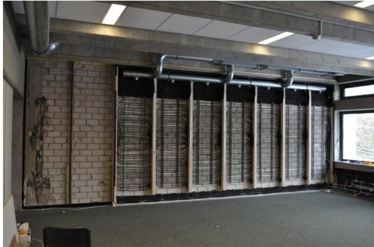
*Abbildung 6-29: Ansicht der Klimawand im Rohbau (Sanierung)*
