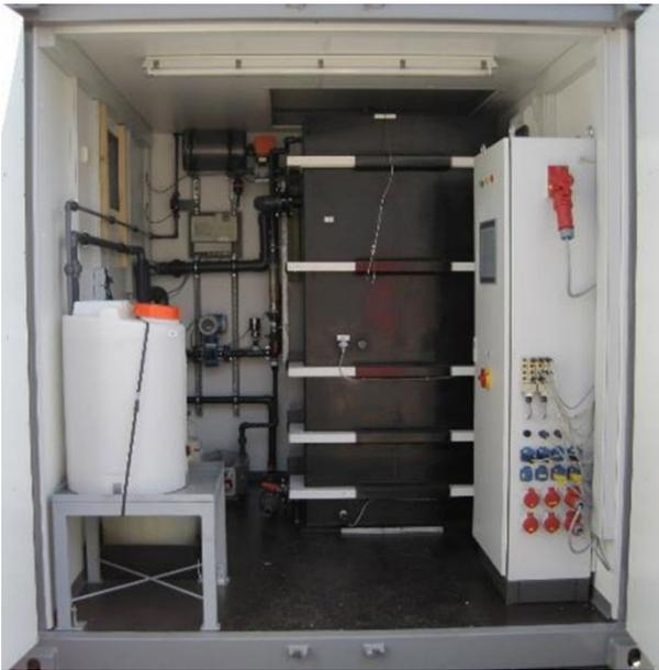
*Abb. 2: Mobiler Membranbelebungsreaktor zur dezentralen Aufbereitung kommunalen Abwassers (ähnlich des in PU<sub>2</sub>R entwickelten MBR)*
