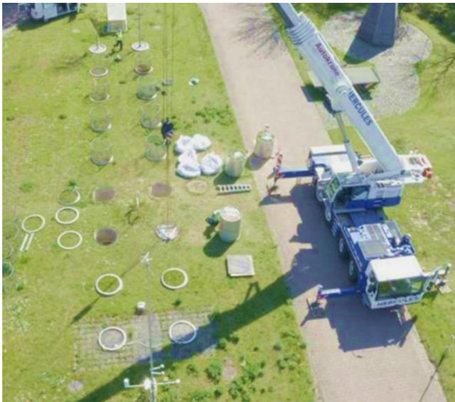
Abb. 4: Einbau des ungestörten Bodenkörpers als Lysimeter am Umweltbundesamt in Berlin-Marienfelde
