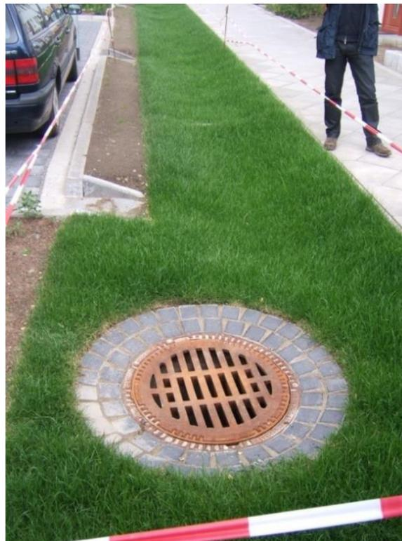
Abb. 1: Muldenversickerung (li.), Schachtversickerung (re.) (Bildquelle: Mathias Uhl)
