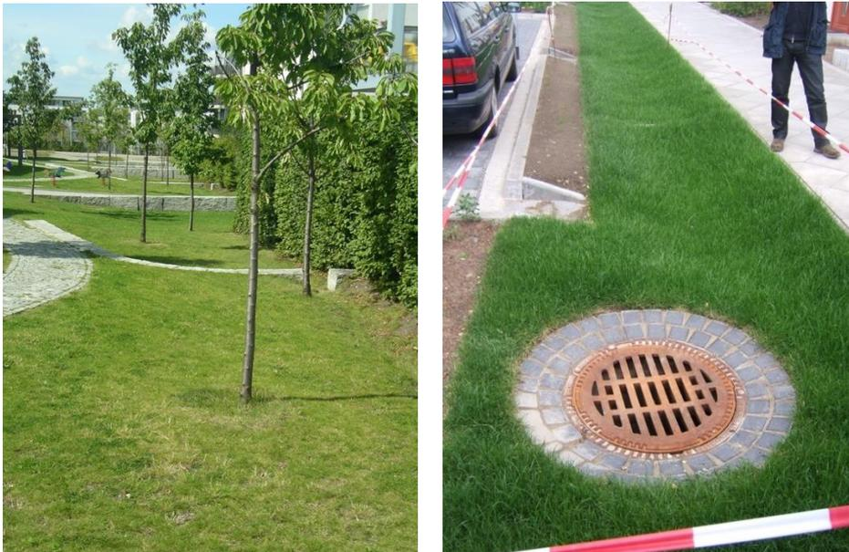
**Abb. 1:** Muldenversickerung (li.), Schachtversickerung (re.) (Bildquelle: Mathias Uhl)
