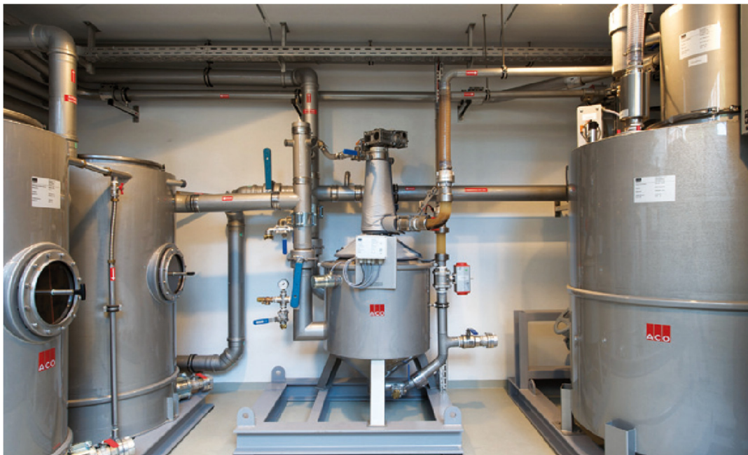
Abbildung 44: Nassmüll-Entsorgung mit Fettabscheider und biologischer Nachbehandlung in Segmentbauweise der Firma ACO Haustechnik nach (Eulerstein 2012)
