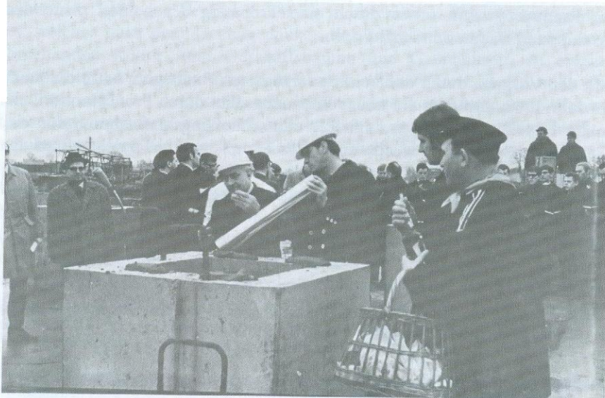
Einmauern der Urkunde bei der Grundsteinlegung Foto: Stadtarchiv Steinfurt, Schulz/Heuping
