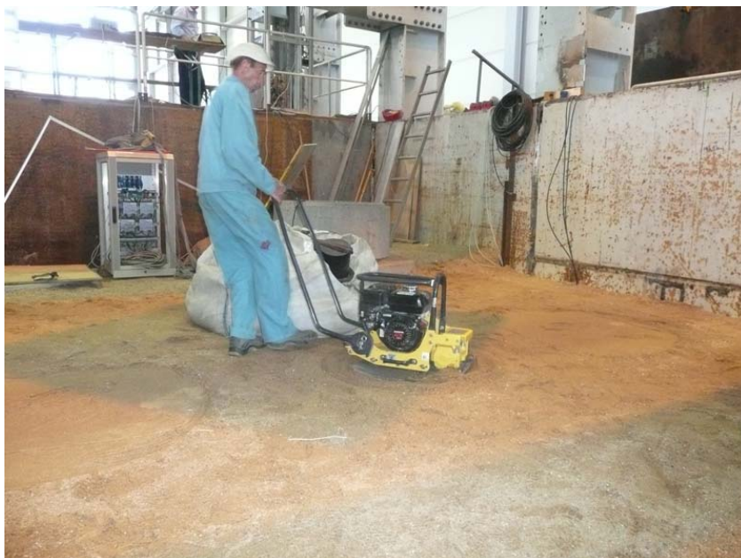
Bild 6-37 Dynamische Belastung infolge Vibrationsverdichter
