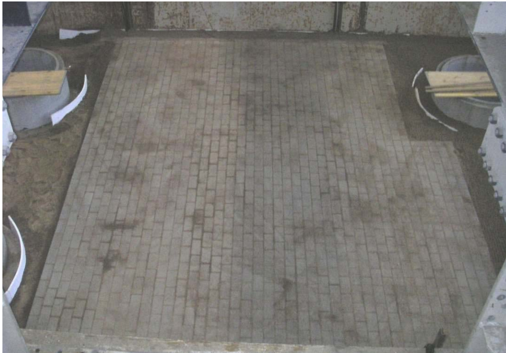
Bild 3-5 Fertiggestellte Pflasterfläche im IKT-Großversuchsstand
