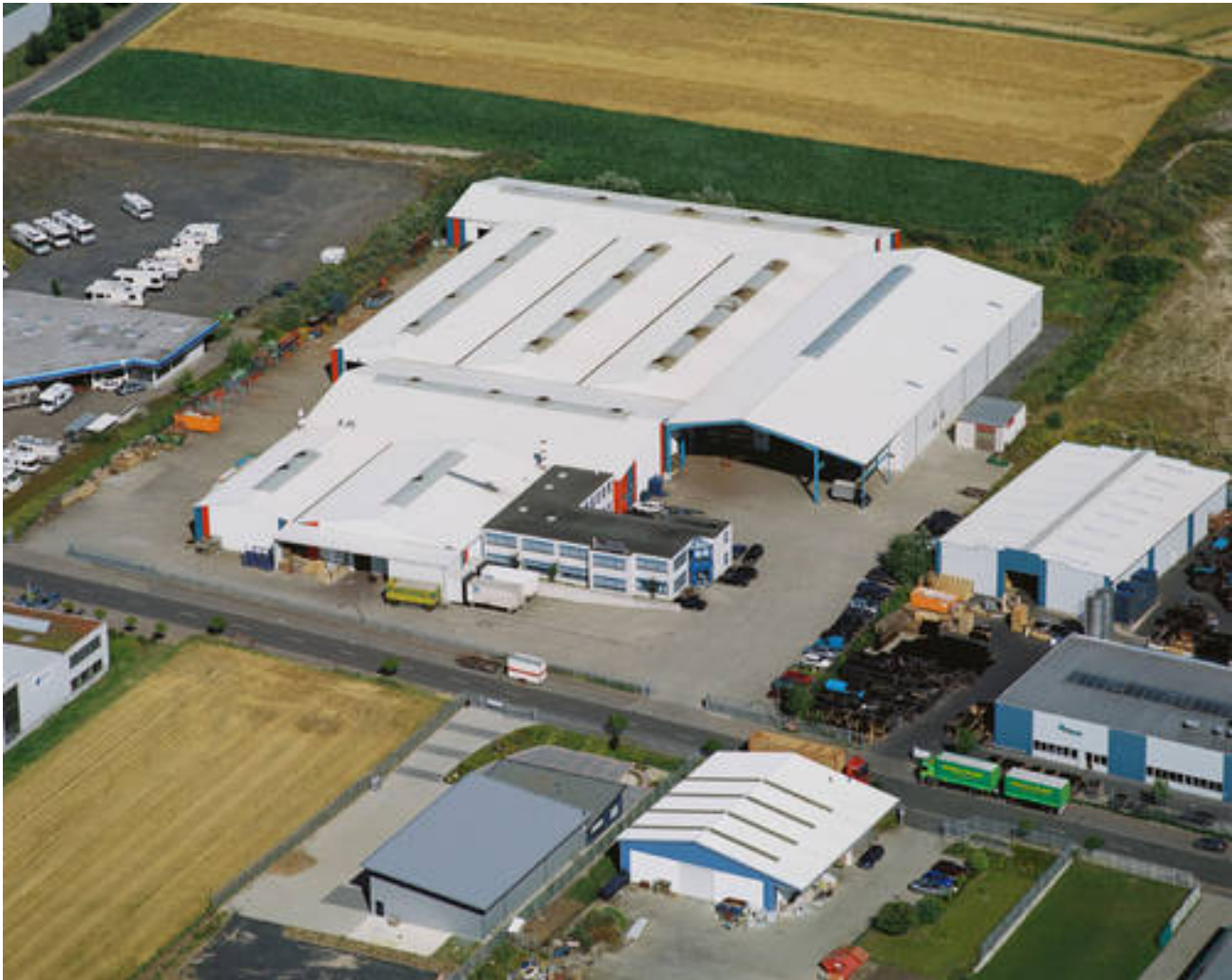
Luftbild der Comfort Sinusverteiler GmbH
