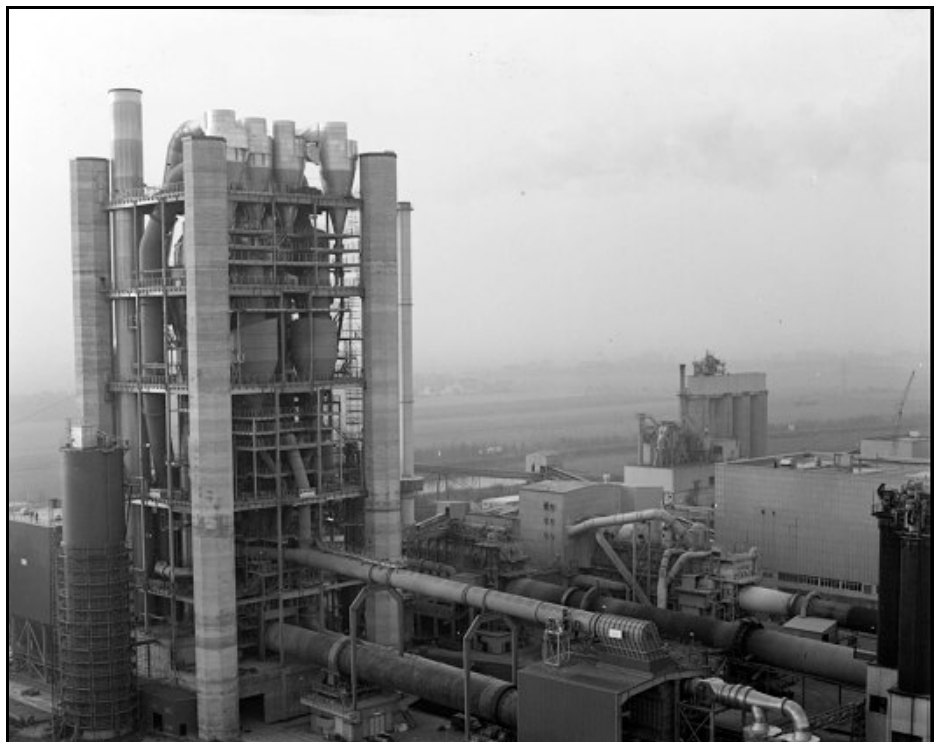
Zementwerk mit Drehrohrofen und Vorwärmerturm
