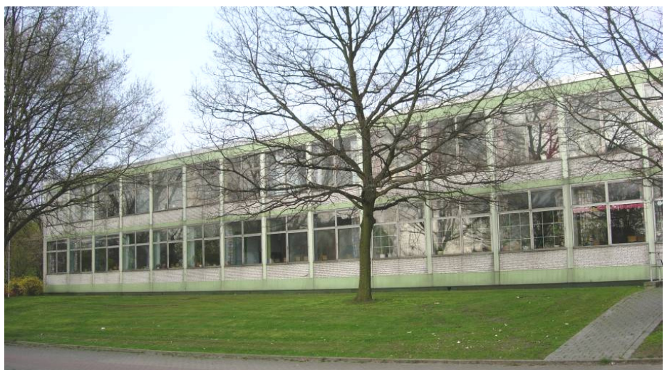
Ansicht auf die Gustaf-Adolf-Schule vor Sanierung
