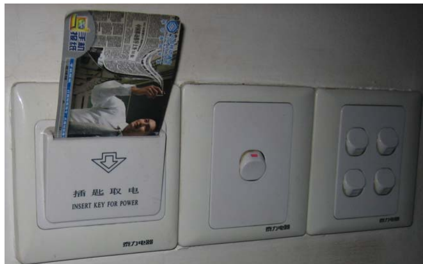
Abb. 9.1 Zwangsfunktionen sollten nur eingesetzt werden, wenn es unbedingt erforderlich ist. Zwangsfunktionen scheinen häufig den Anwender dazu zu veranlassen, sich dem Zwang zu entziehen. Das Foto zeigt eine Vorrichtung aus einem Hotelzimmer zur Abschaltung des Lichtes nach dem Verlassen des Gastes mit seiner Schlüssel-Karte, die mit einer anderen Plastikkarte düpiert wurde.
