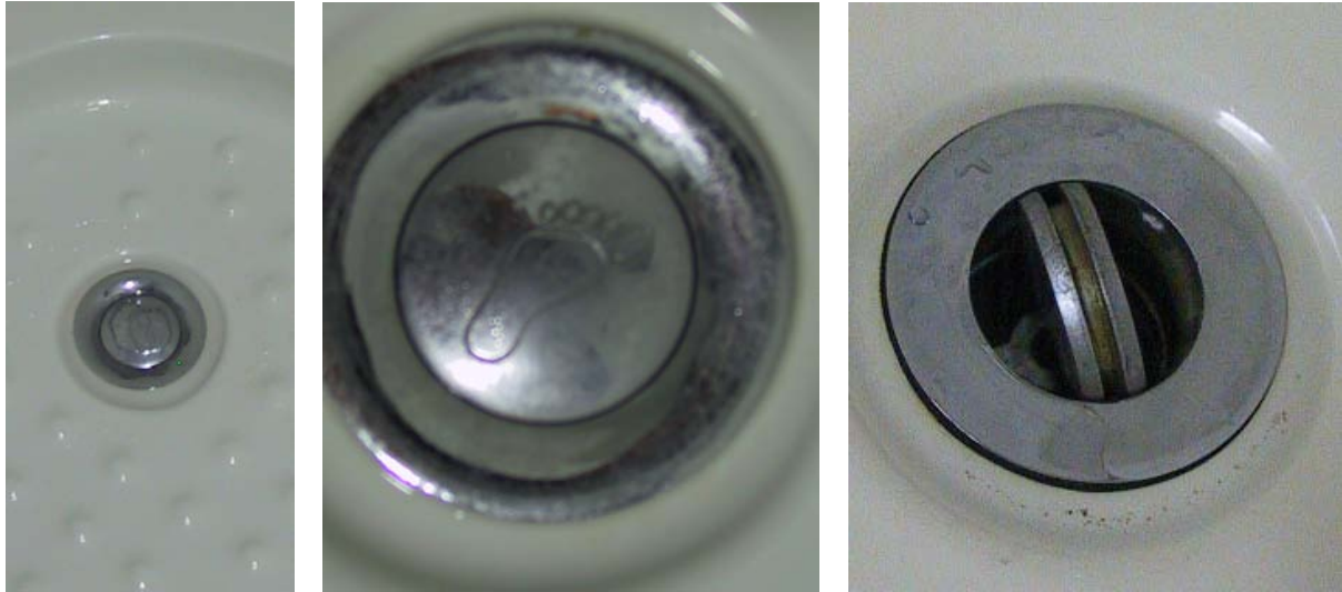
Abb. 5.21 Wannenauslauf: Einfache Gravuren sind häufig schlecht erkennbar
