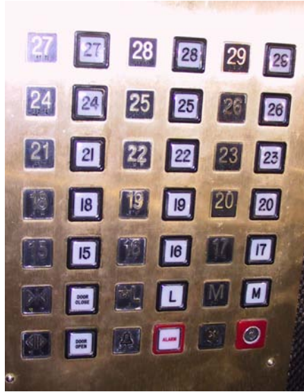
Abb. 5.3 Die Kennzeichnung eines Stellteils sollte so erfolgen, dass Kennzeichnungen nicht versehentlich als Stellteil angesehen und dadurch Fehler provoziert werden
