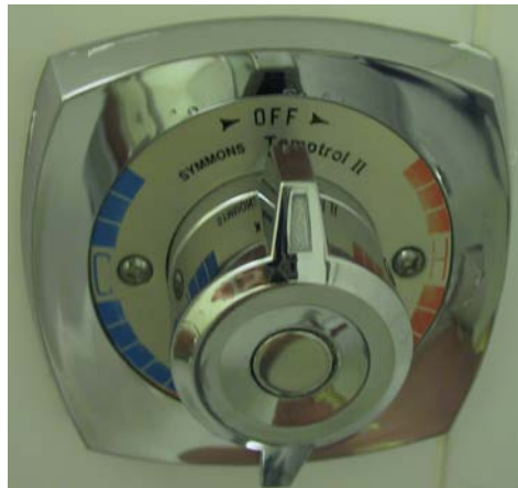
Abb. 5.63 Armatur zur Regelung von Wassermenge und -temperatur: Ein Stellteil, das Menge und Qualität einer Größe gleichzeitig beeinflusst, kann bei Anwendern ohne Erfahrung im Umgang zu Fehleinstellungen führen.
