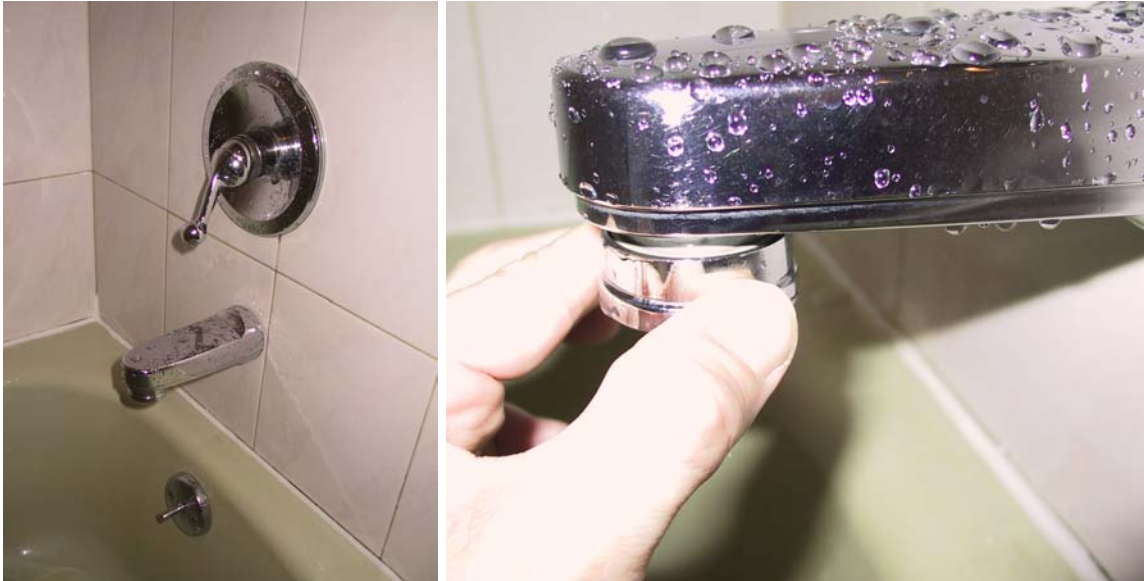
Abb. 5.33 Duscharmatur, Umschalten durch Ziehen am Ring unter dem Wanneneinlauf. Die Sichtbarkeit der Funktionalität ist gering, eine andere Gestaltung könnte einen besseren Formschluss erlauben. Wenn in einem Kulturkreis eine Kennzeichnung oder eine Funktionsanordnung unbekannt ist, resultiert die Konfrontation mit einem solchen Medizinprodukt in Unverständnis und Suche.
