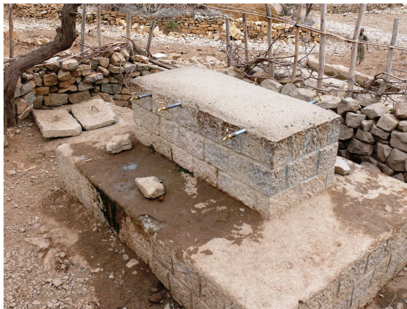
Abbildung 5: Vorhandene Trinkwasserversorgung (Mohn)
