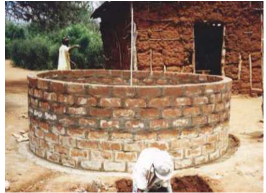
Abbildung 19: Bau einer Zisterne mit ungerannten Steinen (Nissen-Petersen, 2007, S. 13)
