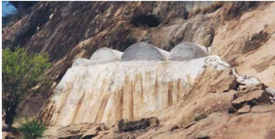
Abbildung 26: Rock Catchment mit gewölbtem Dach
