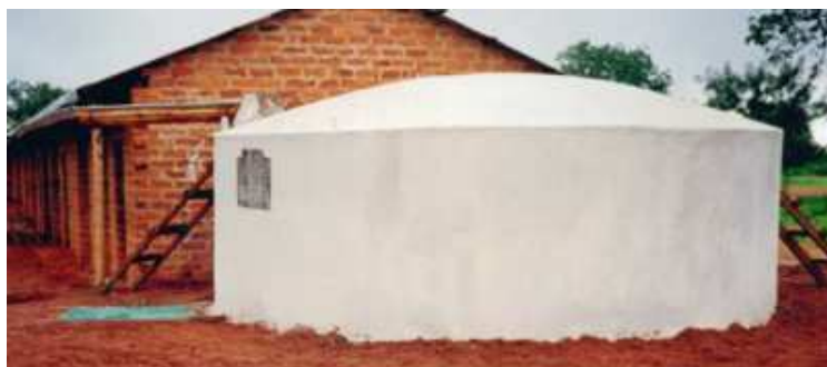
Abbildung 21: Oberirdischer Ferro Cement Tank einer Grundschule in Kenia, (Nissen-Petersen, 2007, S. 59)
