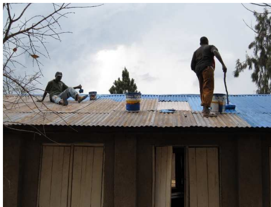
Abbildung 53: Sanierung der Dachfläche (Straub Ingenieure ohne Grenzen)
