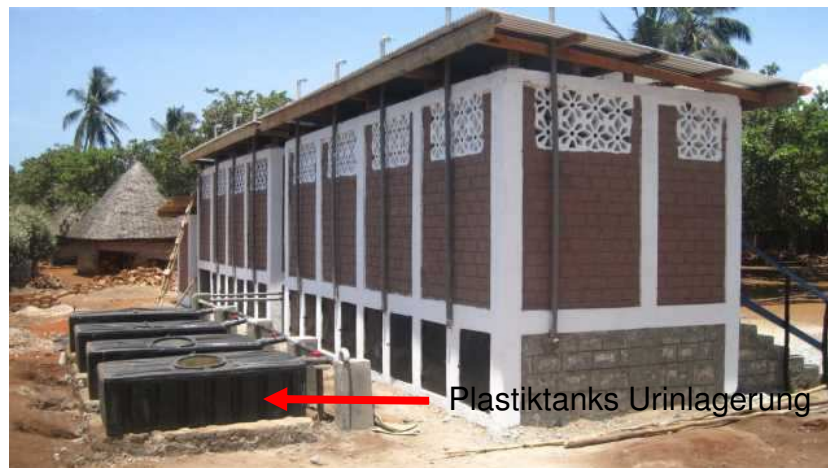
Abbildung 35: Rückansicht der Schultoiletten in Ukunda (Ingenieure ohne Grenzen, Aachen)
