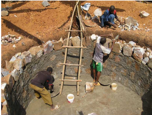
Abbildung 18: Bau einer Zisterne mit Bruchsteinen (Straub Ingenieure ohne Grenzen)
