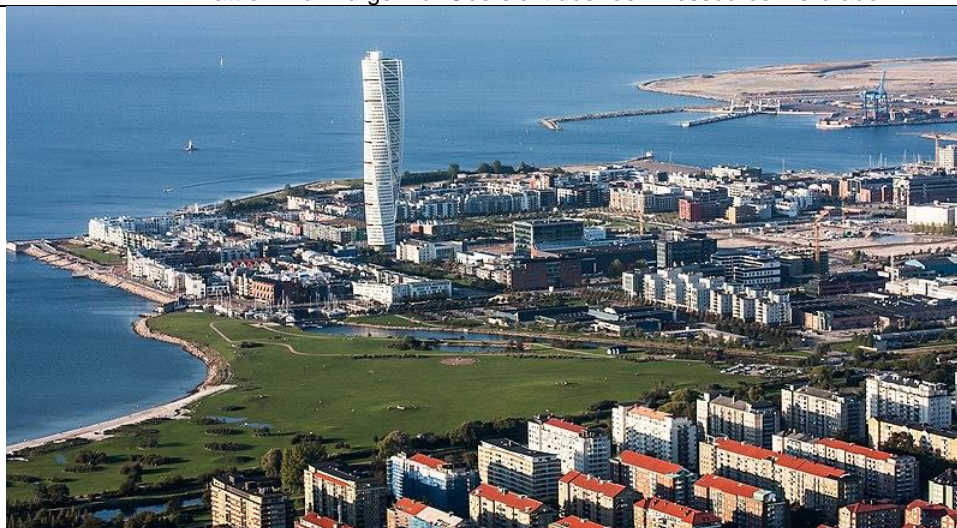
Abbildung 11. Luftbild mit Blick auf das Teilgebiet Bo1 und den Turning Torso (CC0 David Castor)
