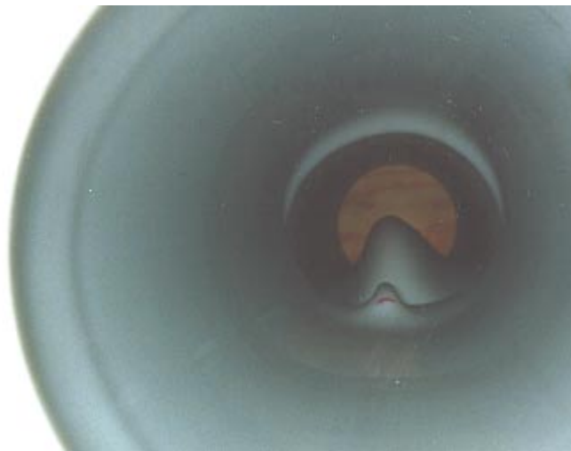
Bild 5 Blick in das durch einen U-Liner sanierte Rohr (Bild 4) nach dem Beulen des ovalen Mittelteils
