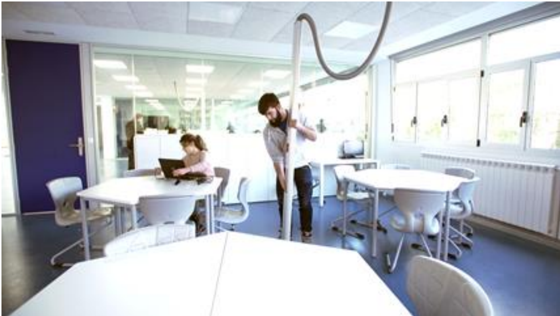
Abbildung 6.8: Säulen mit elektrischen Anschlüssen (Ethazi Tknika, 2021)
