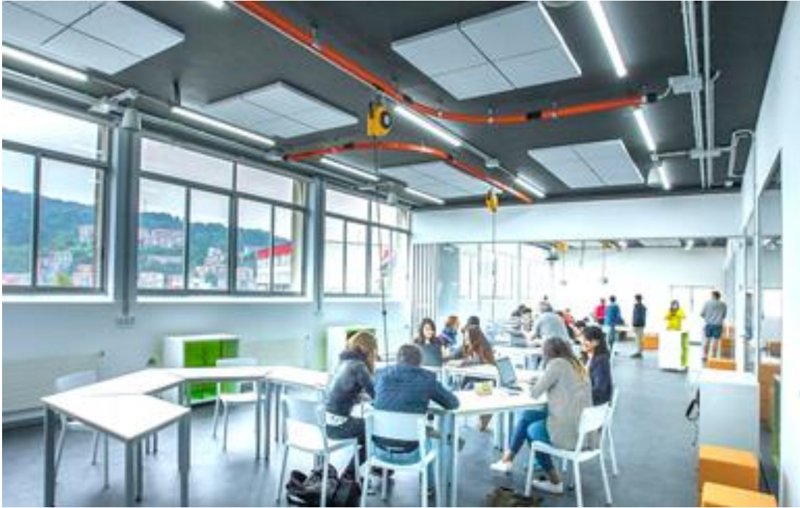
Abbildung 6.9: Akustikdecken im Lernraum (Ethazi Tknika, 2021)
