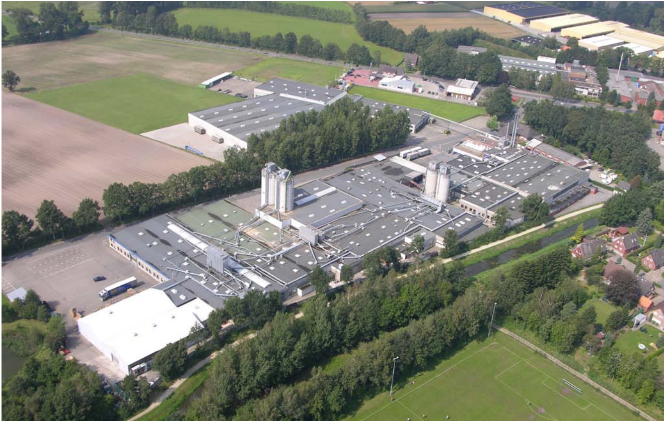
Luftbild des Betriebs
