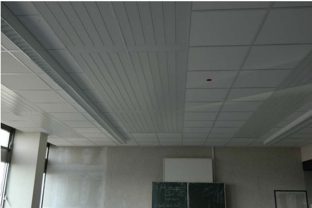
Fertig montierte Deckenheizung im Klassenraum
