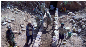
Der Damm wird oberirdisch von einer Trockenmauer geschützt und innen verdichtet.
