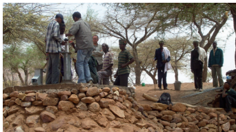
Der Handpumpe des Brunnens wird installiert. Der Brunnen wird von einer Platte aus Beton geschützt.
